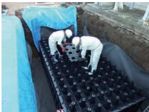
第3図 貯留ブロックの組立状況 Fig. 3 Assembly of the water storage blocks
