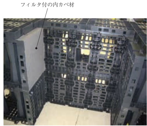
第 11 図 内カベ材の組立状況 Fig. 11 Assembly of the inner cover blocks
