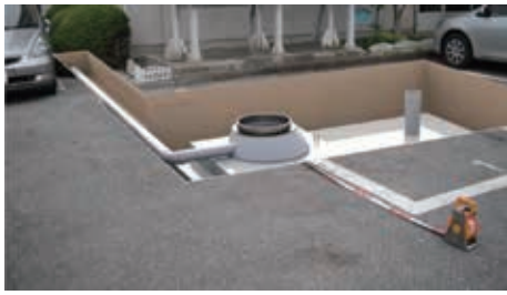
第 8 図 マンホールの配置 Fig. 8 Installation of the manhole
