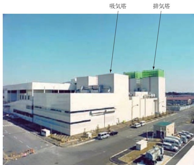
大型ファンエンジン試運転用騒音低減施設（全景）
