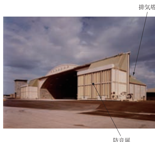
ハンガ型航空機地上試運転用騒音低減施設
