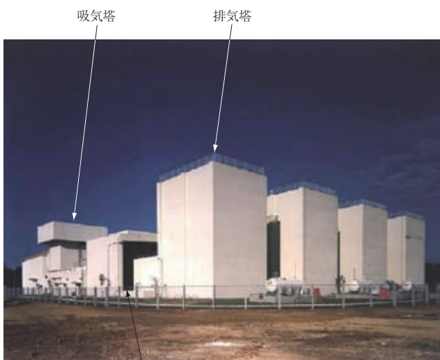
空冷式低バイパス比ファンエンジン試運転用騒音低減施設
