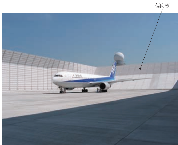
フェンス型航空機地上試運転用騒音低減施設 (B767 試運転中)
