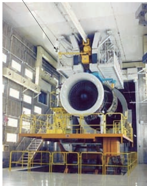
大型ファンエンジン試運転用騒音低減施設（エンジン室）
