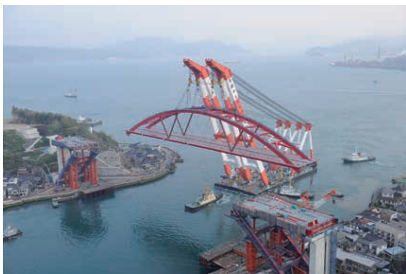
第二音戸大橋の一括架設
