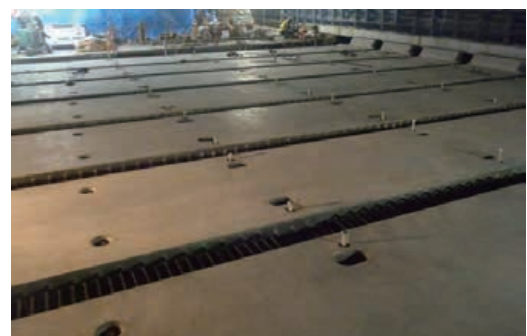
第 15 図 PCa 床版の架設状況 Fig. 15 Installation of PCa slab
