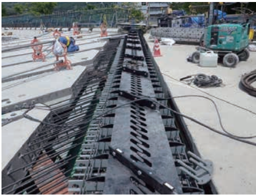
第 16 図 桁端部の PCa 床版敷設状況 Fig. 16 PCa slab and expansion joint at girder end
