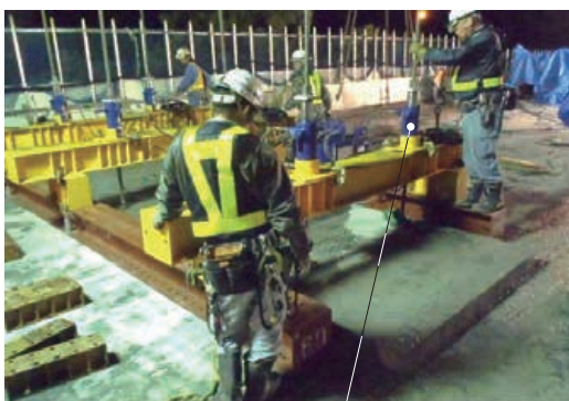
第 13 図 剥離装置による既設 RC 床版の撤去 Fig. 13 Removal of existing RC slab
