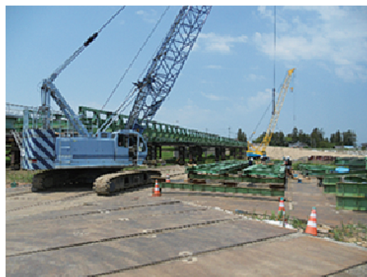
パネルの平面組立状況
