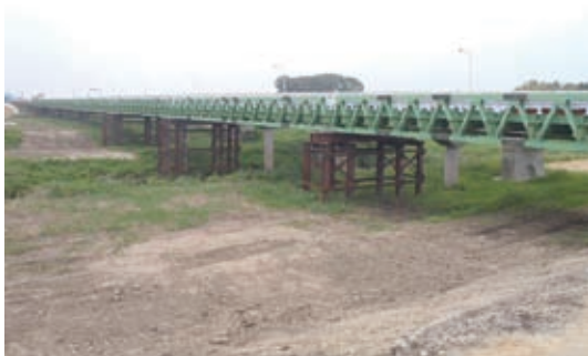
完成した災害復旧用の橋
