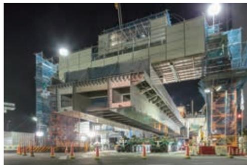
第 9 図 門型吊上げ式ベントによる架設状況
