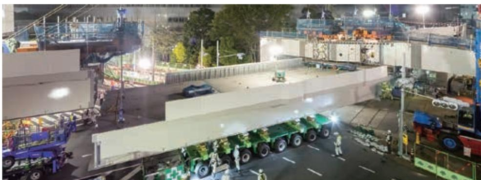
第 11 図 閉合ブロックの一括吊上げ架設
