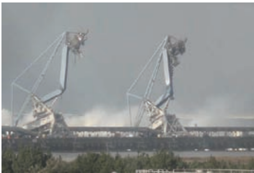
第 3 図 アンローダの震災後と復旧後
