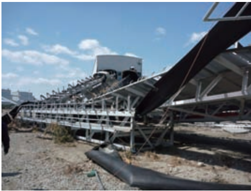
第 2 図 津波によって倒壊した BC2 コンベヤ Fig. 2 BC2 conveyor destroyed during the tsunami
