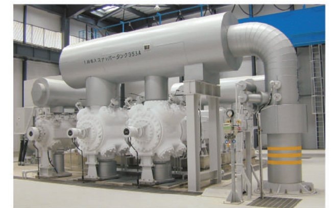
世界最高の吐出圧力6.5MPaのBOG圧縮機
