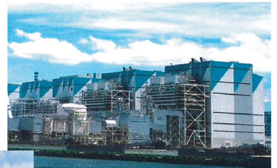
碧南火力発電所全景 右から3つめが3号ボイラの系列(その右の4号、5号系列もボイラはIHI製) 3、4、5号ボイラの再熱蒸気温度593℃
