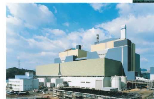
橘湾火力発電所(右側がIHI製1号ボイラ) 1号ボイラの再熱蒸気温度は610℃
