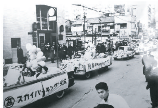
高島屋一号機竣工パレード
