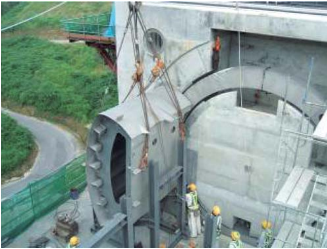
第4図 扉体シェル端部ブロックの据付け状況
