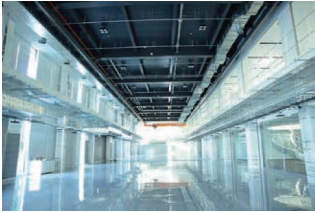
1階吹き抜け部
