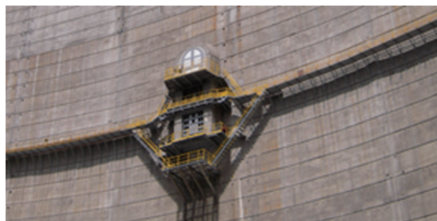
高圧ゲートの取替工事
