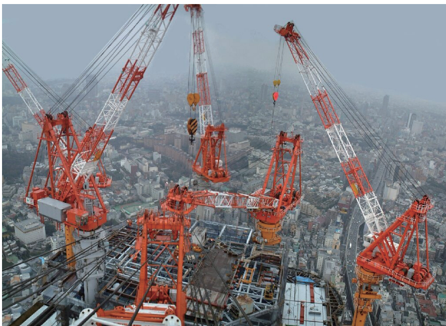
第1図 ビル建設中のJCC群（起伏ジブ式）
