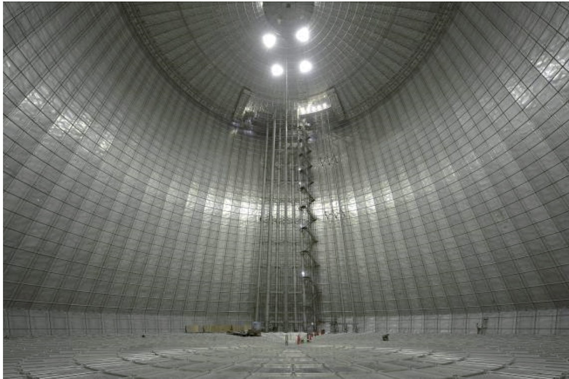
最新の技術を結集し大容量化を実現した世界最大 25 万 KL の LNG 地下タンク（2013 年完成） （東京ガス株式会社扇島工場向け TL22LNG 地下タンク）
