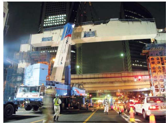
第 12 図 P4 橋脚横梁一括架設 Fig. 12 Erection of pier beam (P4)
