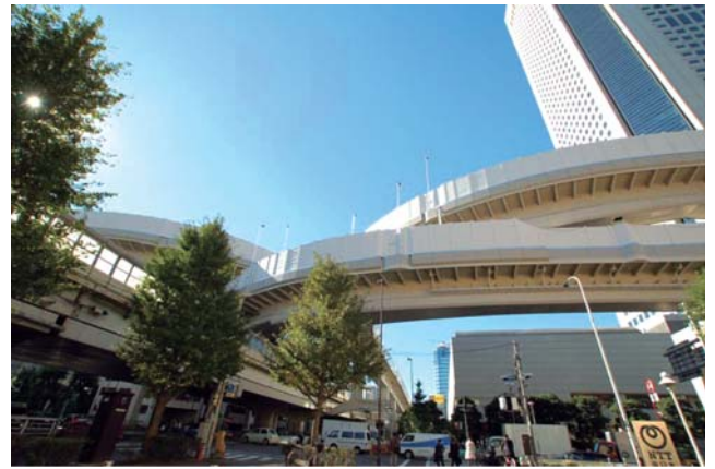
第 21 図 「西新宿ジャンクション」外観 Fig. 21 Appearance of "Nishi-Shinjuku junction"
