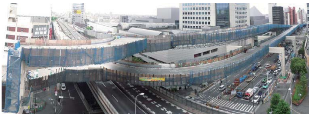
第 2 図 架設完了後の全景 Fig. 2 Completed bridge
