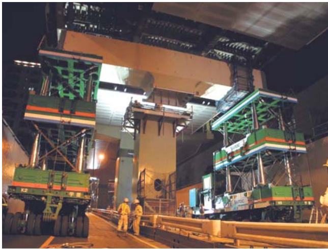
第 11 図 多軸台車とテーブルリフタによる横梁架設 Fig. 11 Beam construction with multi-axial winches and table lifter
