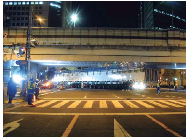
第 13 図 多軸台車による上部工大ブロックの搬入 Fig. 13 Conveyance of a large girder block by multi axial winches
