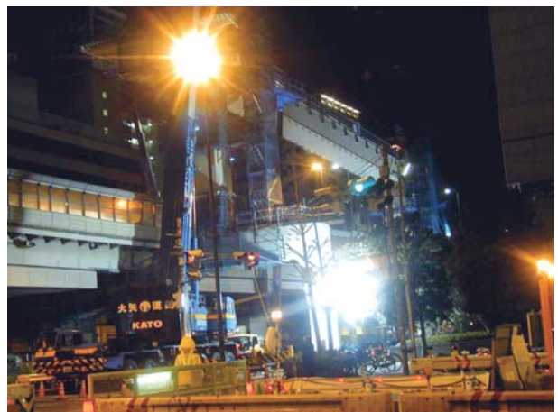
第 14 図 相吊りによる大ブロック一括架設 Fig. 14 Erection of large block by the double-lifting method
