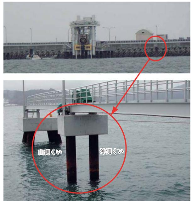
第 12 図 試験対象鋼管ぐいの外観
