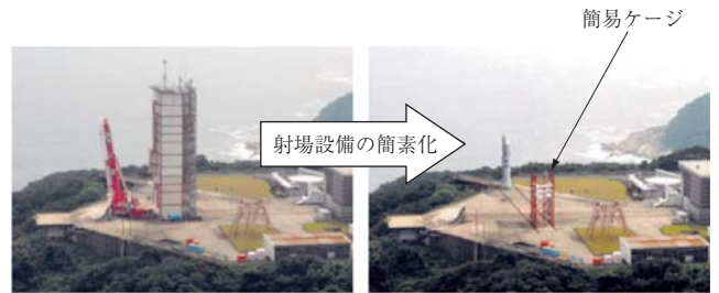
第11図 移設可能な射点構想（簡易ケージ） Fig. 11 Mobile launch pad with compact cage
