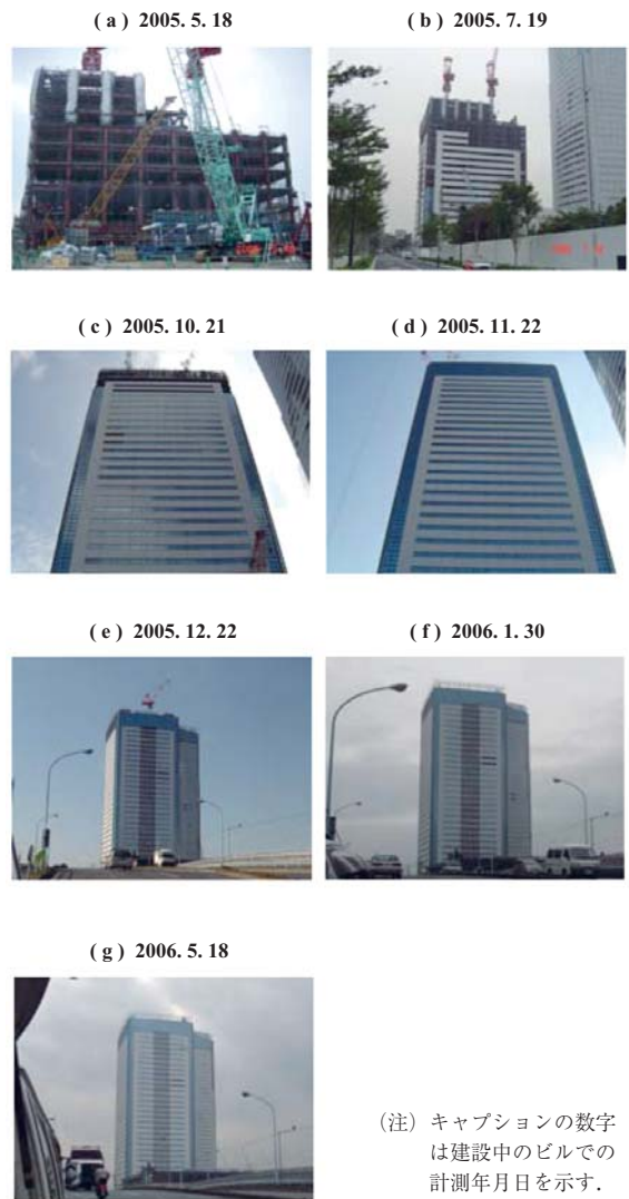
第 20 図 建設中のビルの外観 Fig. 20 Building under construction
