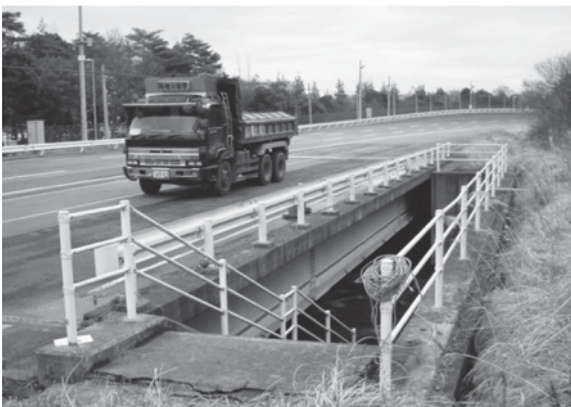
第 8 図 載荷試験状況 Fig. 8 Status of loading tests
