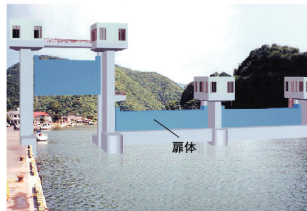
引き上げ式ゲートの設置イメージ
