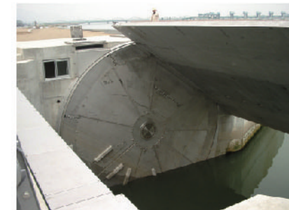
高潮対策設備採用例 (高潮発生時に閉鎖して内陸被害を防ぐ)
