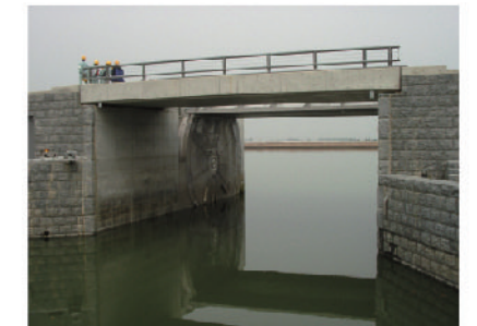
高潮対策設備採用例 (高潮発生時に閉鎖して内陸被害を防ぐ)
