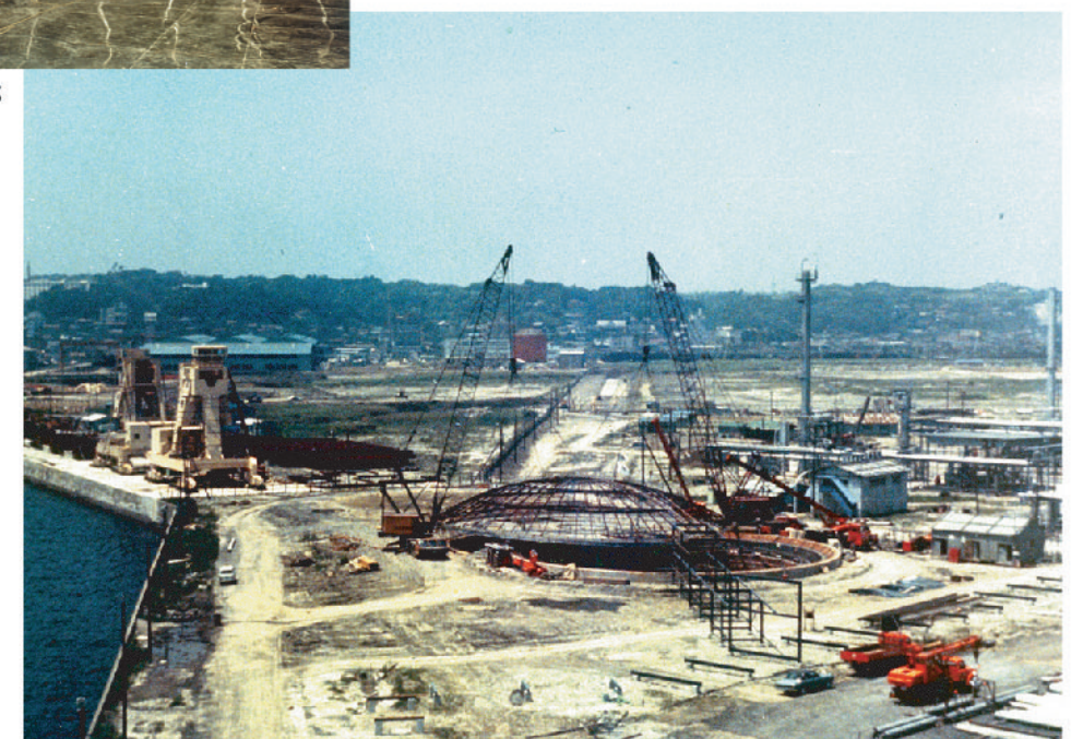
東京ガス根岸工場1万kl地下タンク屋根移設状況
