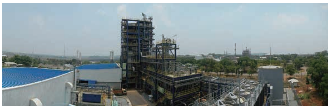
インドネシア実証機 ( 50 t/d ) プラント全景 ( 中央 : TIGAR ® ガス化炉架構 )
