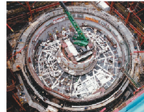
ABWR (柏崎刈羽6号機) 鉄筋コンクリート製原子炉格納容器内配管現地据付
