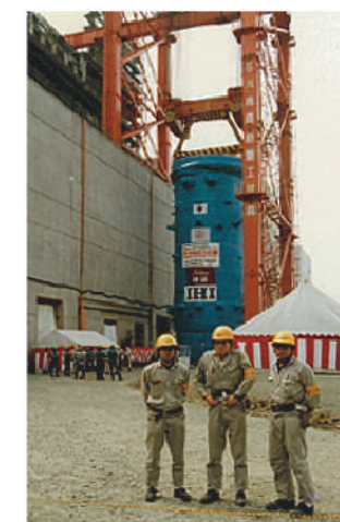
福島第二3号機原子炉压力容器搭載
