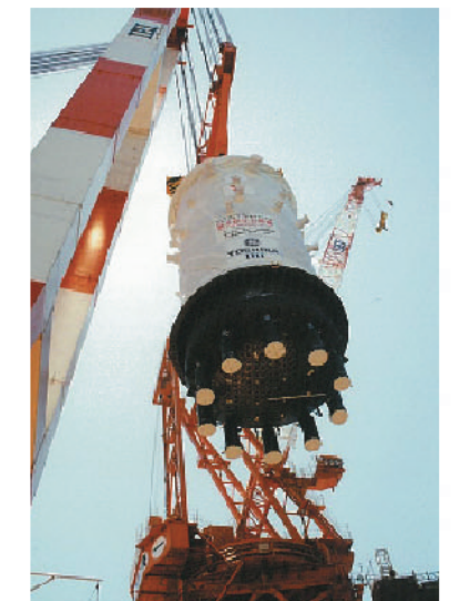
ABWR (柏崎刈羽6号機) 原子炉圧力容器搭載
