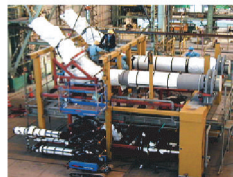
ABWR (柏崎刈羽6号機) 配管ユニット工場製作
