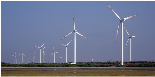
脱化石燃料を後押しする風力発電所
