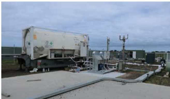
回収した CO 2 の地中への圧入サイトでの圧入の様子
