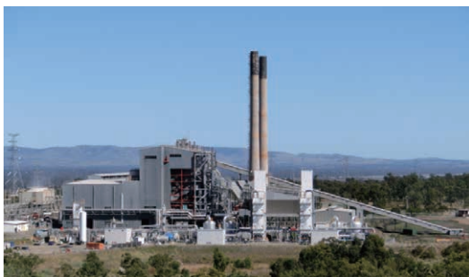
オーストラリア・カライド発電所 (30 MWe 級)
