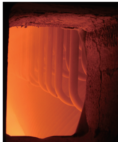
700°C級過熱器炉内状況
