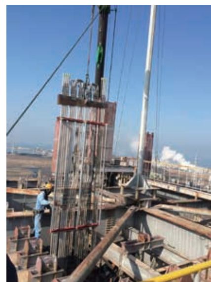
700°C級実証試験ループ据付状況
