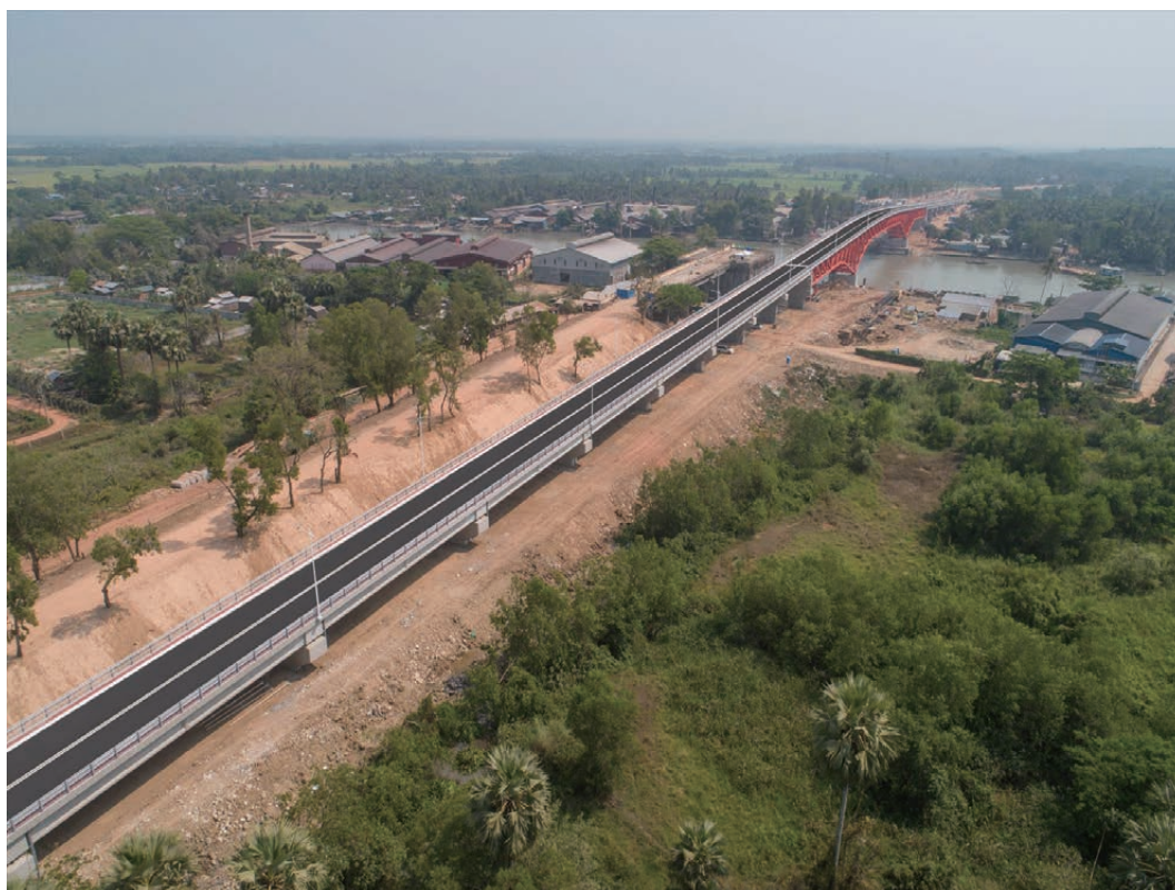
「新ミャウンミャ橋」Patheingyi 側アプローチ橋全景
