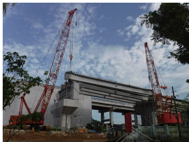
PC 桁架設状況
