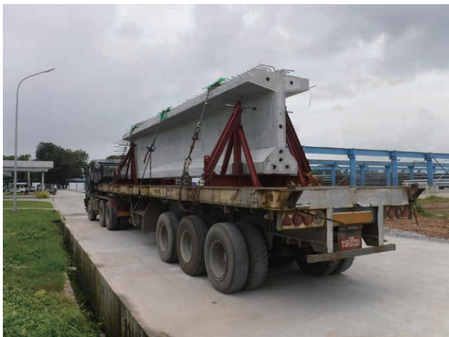
トレーラーでのセグメント運搬
