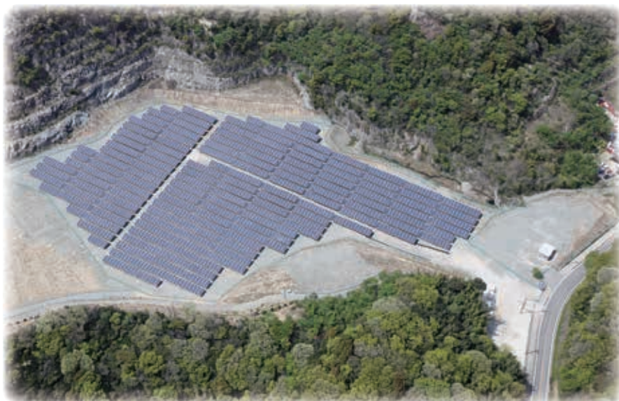
竜野碓岩太陽光発電所 1 734 kW
