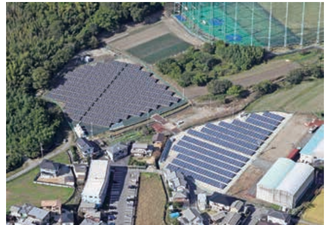
竜野太陽光発電所全景
