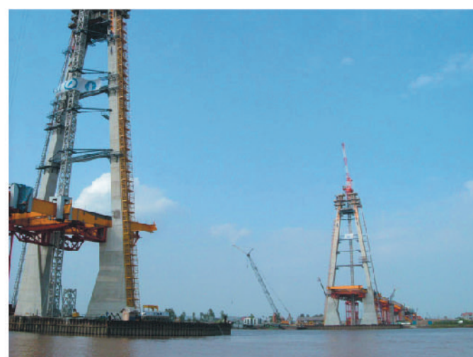
中央径間張出架設開始
