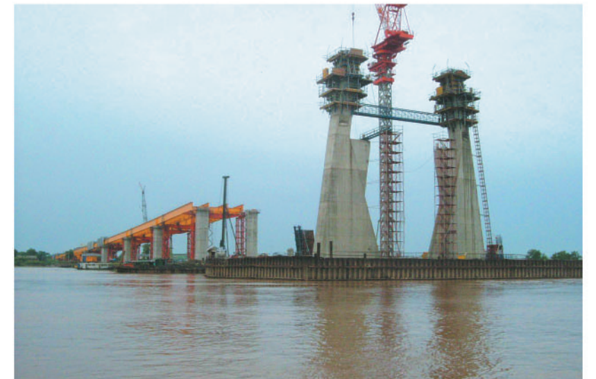
主塔建設工事
