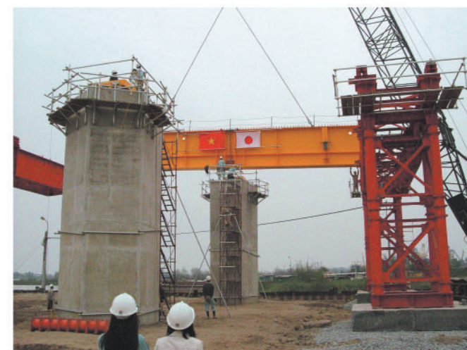
鋼桁初ブロック架設
