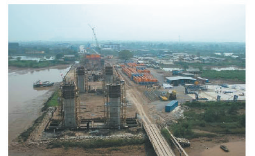
橋脚建設工事全景
