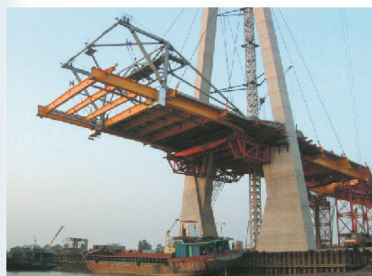
鋼桁張出架設
