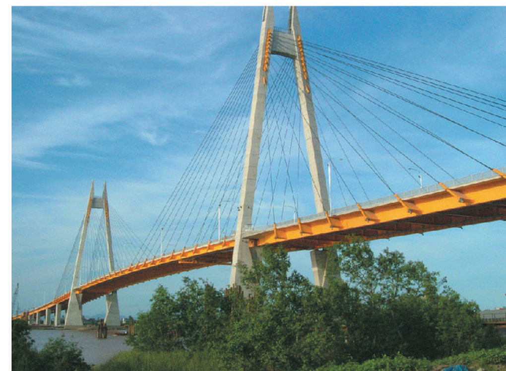
ビン橋完成全景
