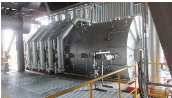
(注) 投入熱量：12 MW 燃焼量：2.4 t/h (アンモニア換算) 寸法：φ3.6×L12 m
