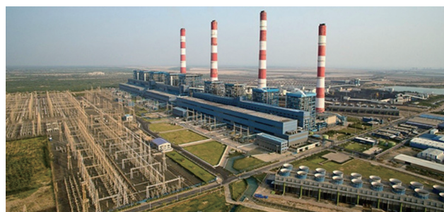
Adani Power Limited Mundra 発電所
