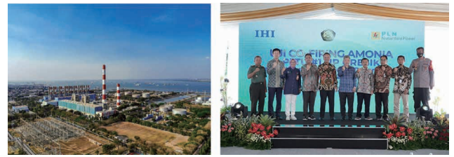
Gresik 発電所および実証試験におけるセレモニーの様子
