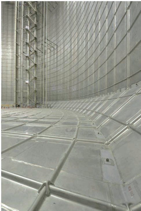
東京ガス株式会社扇島工場 25 万 kL LNG 地下タンク (写真提供：東京ガス株式会社)
