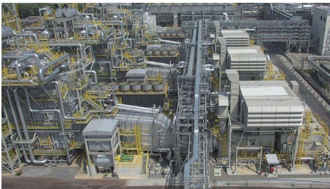
新居浜北火力発電所外観（写真左側：排熱回収ボイラ，右側：ガスタービン発電装置）
