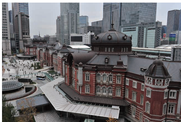
東京駅丸の内駅舎 （写真提供：JR 東日本）
