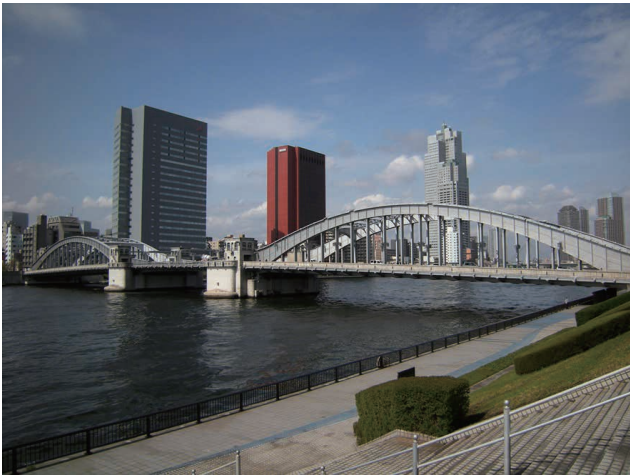
勝開橋 (出典：土木学会「歴史的鋼橋検索」Web サイト)
