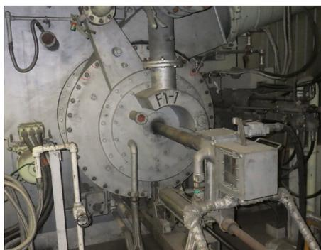
(b) アンモニアノズル設置後
