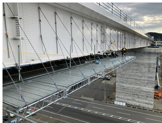
(c) ラピッドフロア施工例
