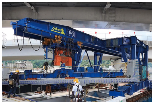
第3図 上空制限下でも施工可能な床版取替機「Sphinx」 Fig. 3 Sphinx, slab replacement equipment enabling work with height limitation
