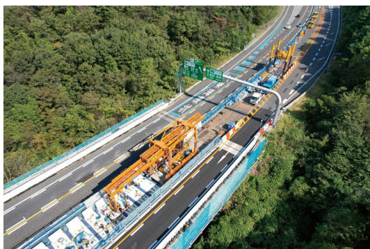
第2図 幅員分割施工可能な床版取替機「EVO」 Fig. 2 EVO, slab replacement equipment enabling lane-by-lane replacement
