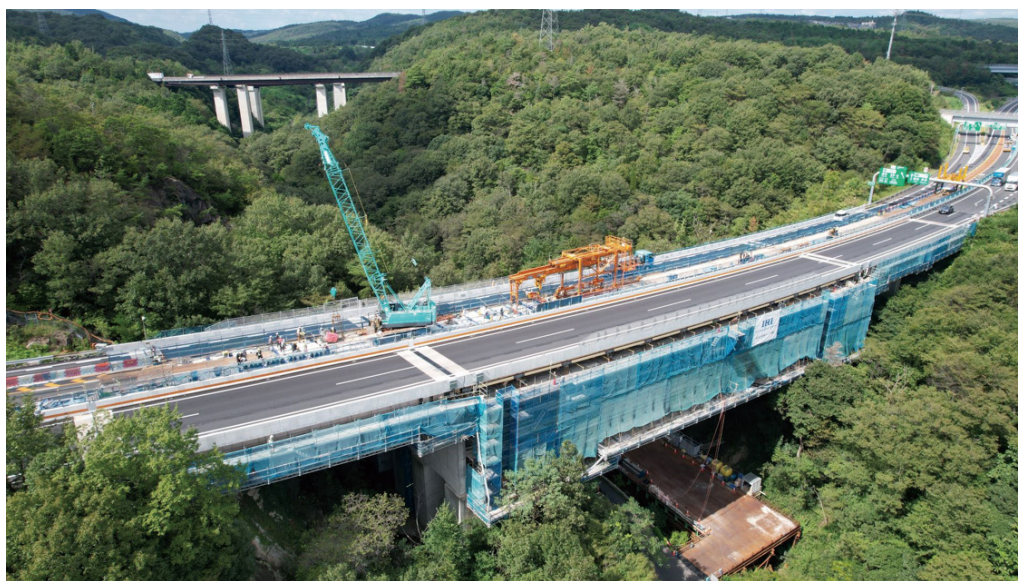
第 1 図 NEXCO 中日本 中央道深沢橋床版取替工事
