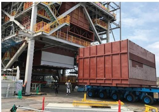
第3図 大型ブロック化したガスエアヒーター搬入の様子
