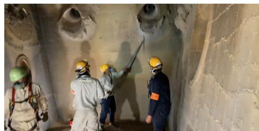
第 9 図 ボイラ火炉下部のボトムアッシュの除去
