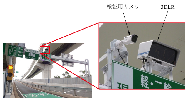
機器設置状況
