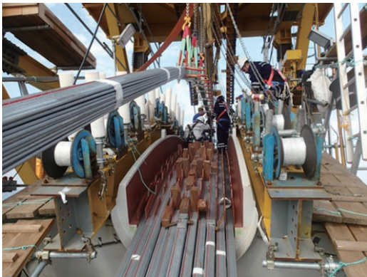
第 8 図 サドルへのケーブルストランド設置 Fig. 8 Installing Cable strand on tower top saddle
