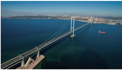
第 7 図 長大吊橋全景（トルコ：「オスマン・ガズィー橋」） Fig. 7 General view of long-span suspension bridge (“Osman Gazi Bridge”)
