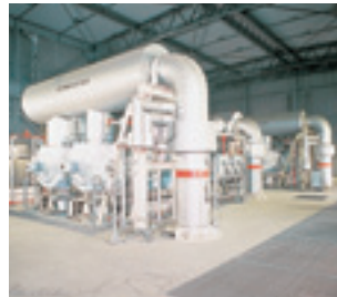
LNG reciprocating compressors
