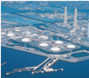
LNG receiving terminals
