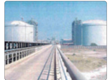
LNG receiving Terminal
