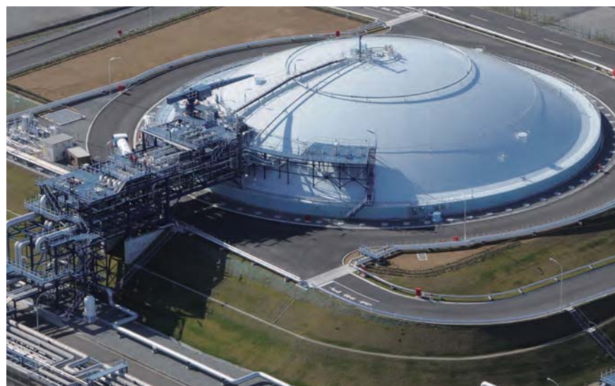
LNG 地下储罐
