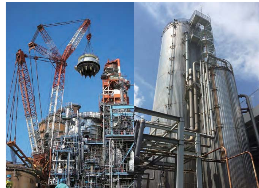
压力容器/废水处理设施
