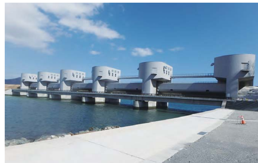
河道用闸门(气仙川水闸)
