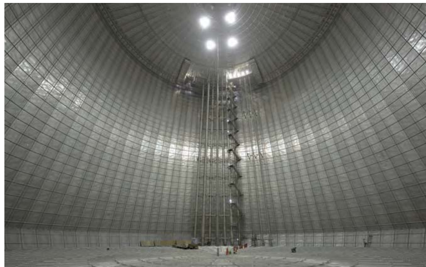
世界最大容量LNG 地下储气罐(膜结构) 照片提供: 东京瓦斯株式会社
