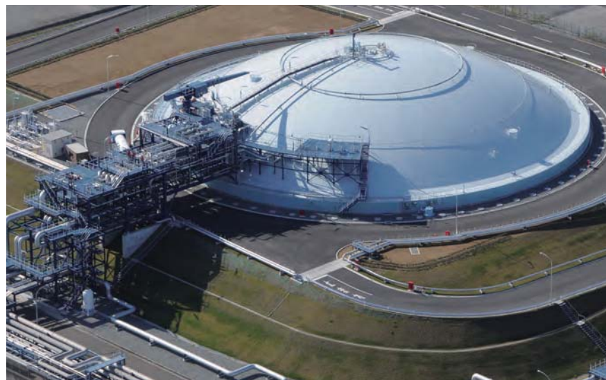
In-ground LNG storage tank
