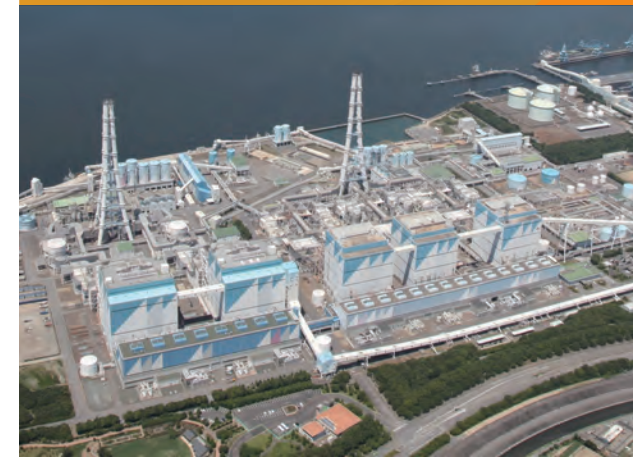
アンモニア燃焼技術 写真提供：株式会社JERA(碧南火力発電所)
