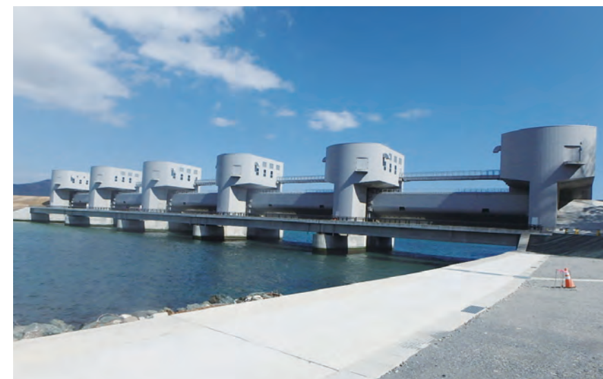
河川用ゲート(気仙川水門)
