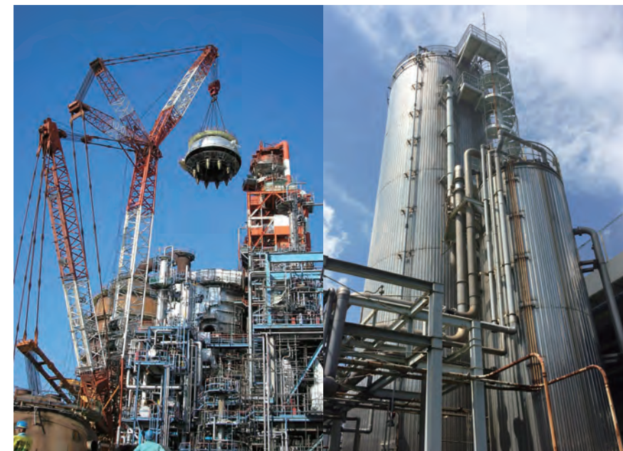
圧力容器 / 排水処理設備
