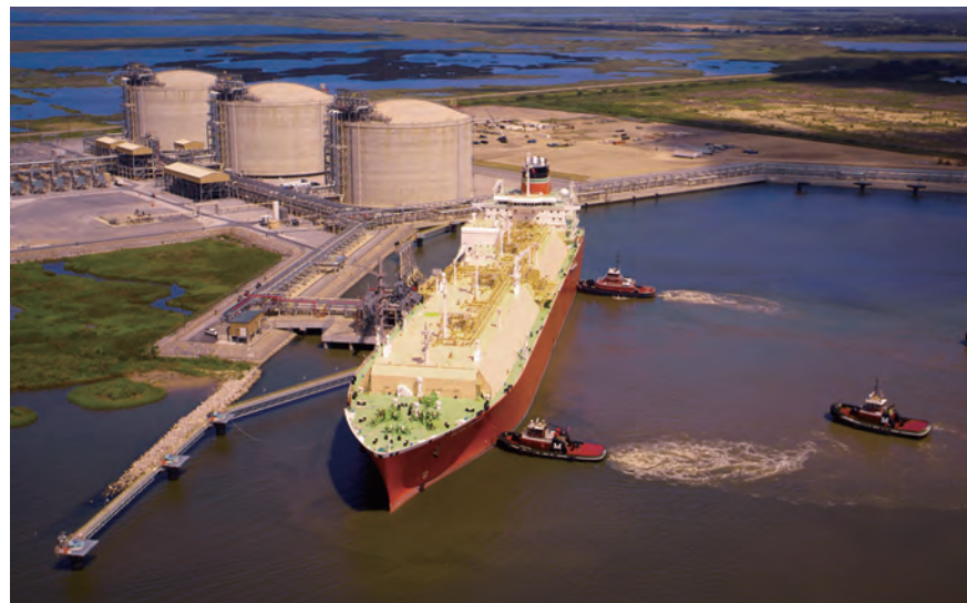
LNG受入基地 (Sempra向けCameron LNG受入基地(米国ルイジアナ州)) Photo used with the permission of Sempra LNG ©All rights reserved by Sempra LNG
