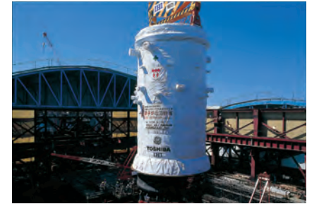
原子炉圧力容器
