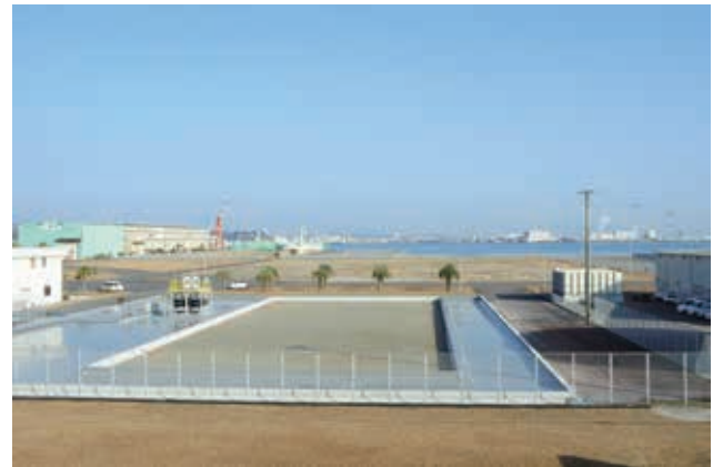
建設中の屋外大規模培養試験設備
