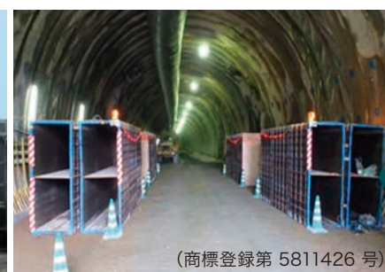
サイレンスチューブ (低周波音低減装置)
